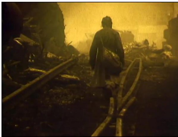
Abbildung 51: Zerstörte Infrastruktur (LUPOSHANSKIY 1986: 8:37)
